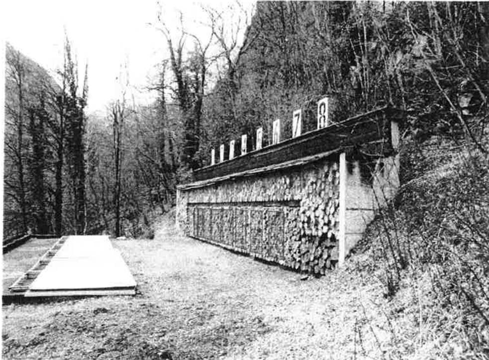
**Figura 5** Sistema parapalle con cassoni (ipotesi di progetto)
